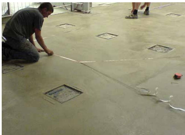
3 Collage des feuillards de cuivre en respectant les intervalles/le quadrillage prescrits.
