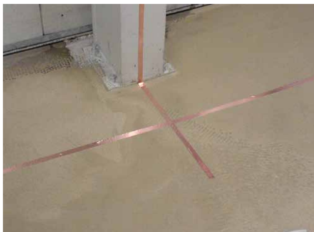
4 Pose de feuillard de cuivre aux éléments de construction montants pour un raccord, ensuite, à la terre.
