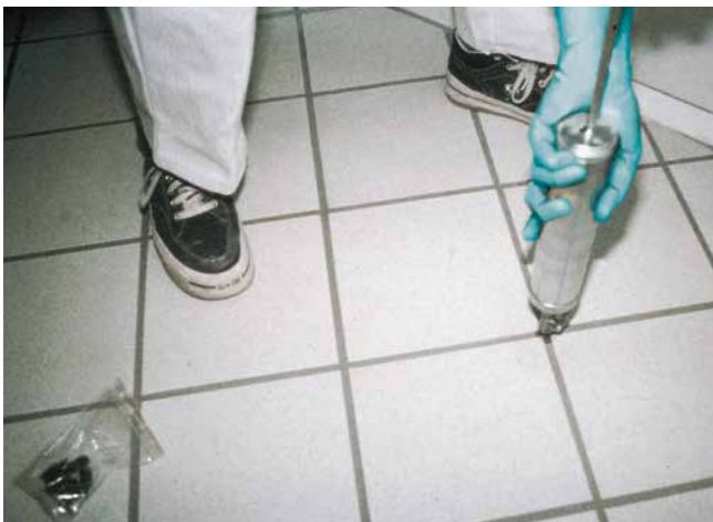
Injection à la seringue pour les petites superficies.
