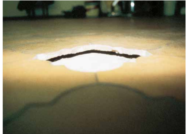
Revêtement de sol sur „zone creuse”
