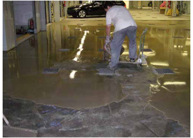
Application du Ragréage autonivellant Sopro FS 15 plus.
