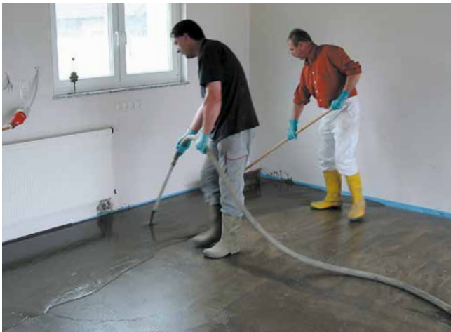
Application mécanique facile du Ragréage autonivellant très résistant SoproDur® HF-S 563
