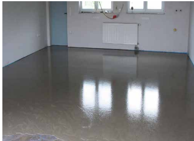
Sol plan, insensible à l'abrasion après durcissement
