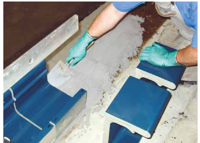
Pose d'éléments de margelle de bassin avec le Mortier époxy Sopro EE 771.
