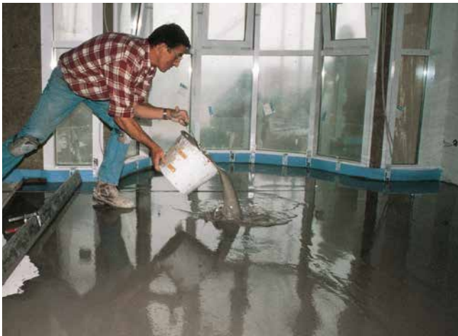
Application du Ragréage autonivellant pour supports anhydrites Sopro AFS 561
